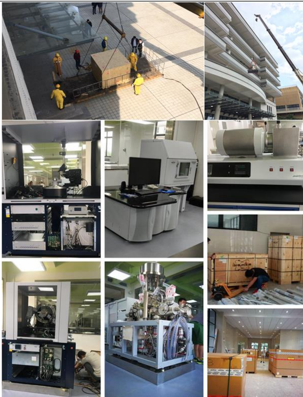
设备近场和安装调试现场
