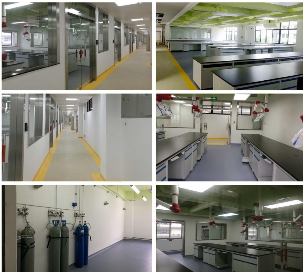
装修改造后实验室现场实景
