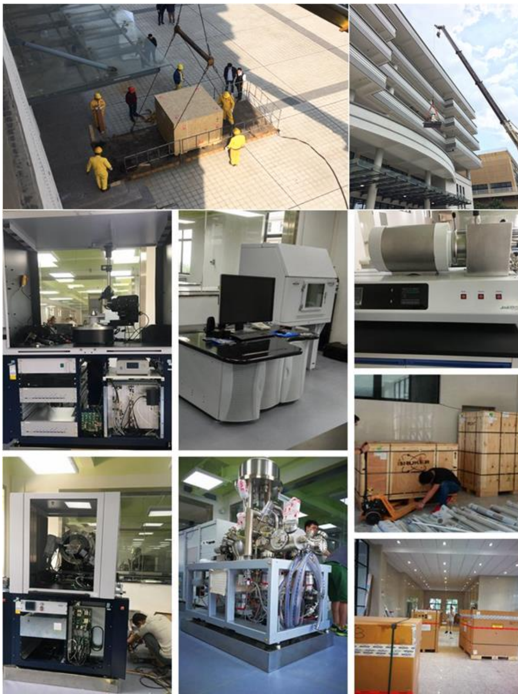
设备进场和安装调试现场
